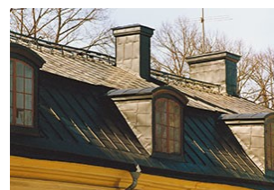
Bild 13:19. Tak med platsmålad förzinkad stålplåt. Foto: Torbjörn Osterling
