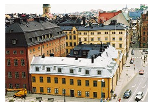
Bild 13:18. Tak med förzinkad stålplåt för senare platsmålning. Foto: Torbjörn Osterling
